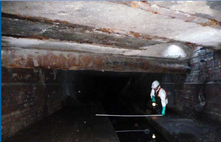
Rechteckquerschnitt unter der Straße mit breiter Berme.
